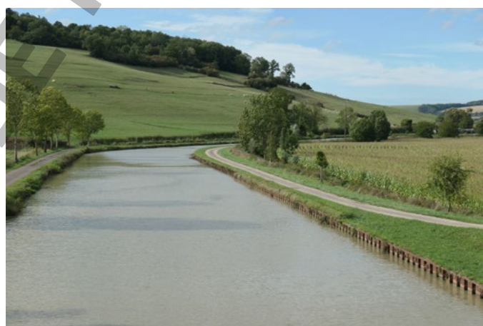
Les dimensions et le caractère linéaire du canal de Bourgogne renforce son rôle structurant dans les paysages.
