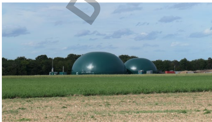
Compte tenu de sa localisation, l'unité de méthanisation de Quincerot n'est perceptible que de manière ponctuelle.
