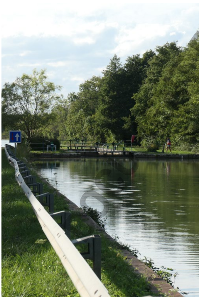
Des écluses et divers aménagements techniques ponctuent le tracé du canal de Bourgogne.
