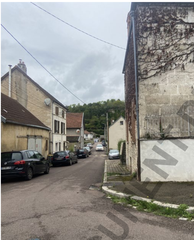
Le faubourg de Montbard présente un caractère urbain, voire routier.
