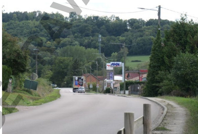
Entre Montbard et Crépand, la zone artisanale génère des perceptions au caractère routier.
