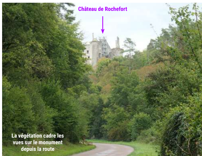
Vue partielle en direction du château de Rochefort depuis la route départementale D5d
