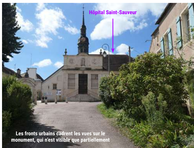
Vue rapprochée sur le monument depuis ses abords immédiats
