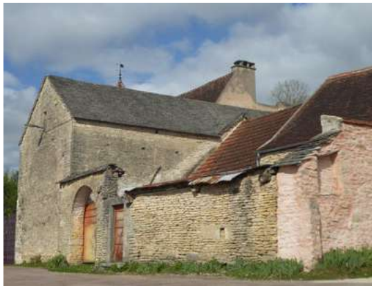
Ci-contre, vue d'une ferme sur la rue Saint-Rémy dont l'une des dépendances a conservé son mode de couverture traditionnel, en laves, récemment rénovées.
