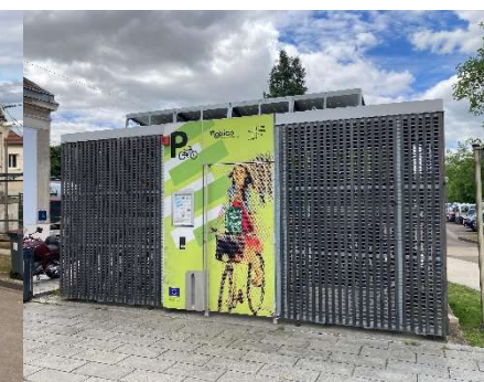
Abri vélo, gare de Montbard.
