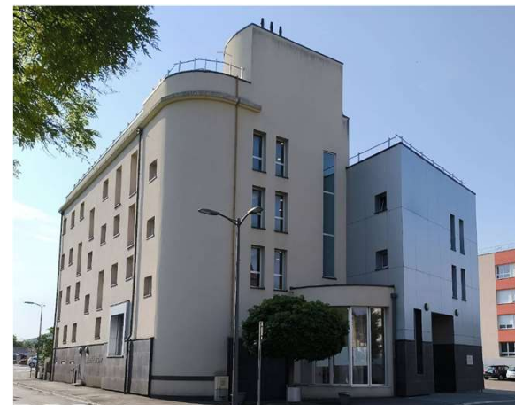
La maison de santé de Montbard. Source : googlemaps
