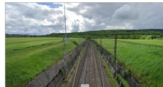
Voie ferrée : tranchée imperméable
